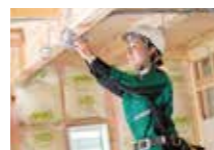
現場での施工作業は一人でこなします。
